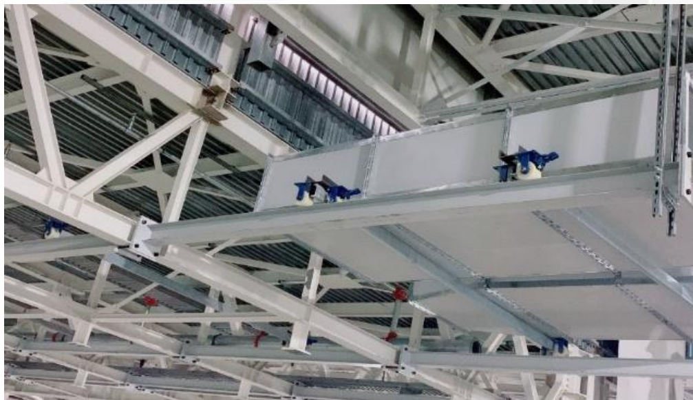
风管 安装 轨道 运输 平台
